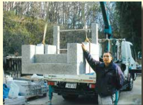
外柵も組んで吊り下げってみました
