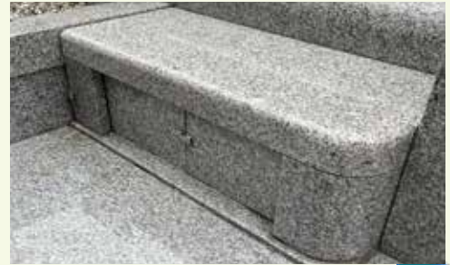
ベンチの扉が閉まった状態
